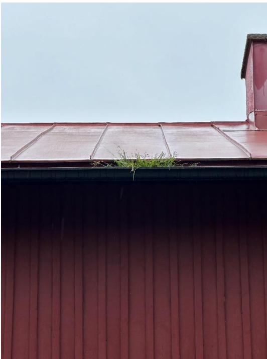
Kuva 15. Rännikourussa kasvillisuutta
