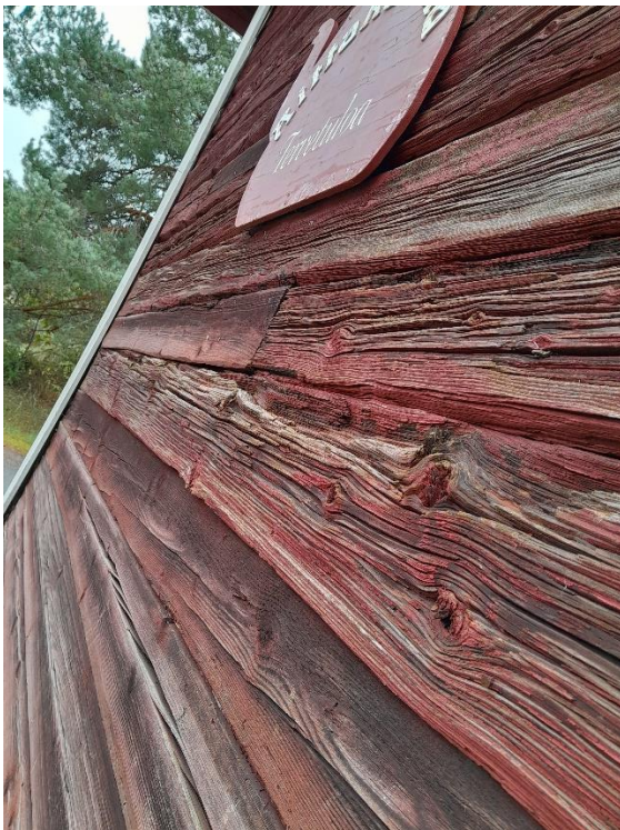
Kuva 24. Aittakahvilan hirsirakenteiset ulkoseinät ovat erittäin huonossa kunnossa
