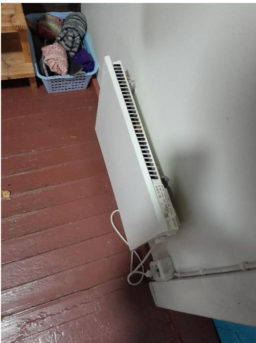
Kuva 39. Sähköpatteri puolikiinteällä asennuksella
