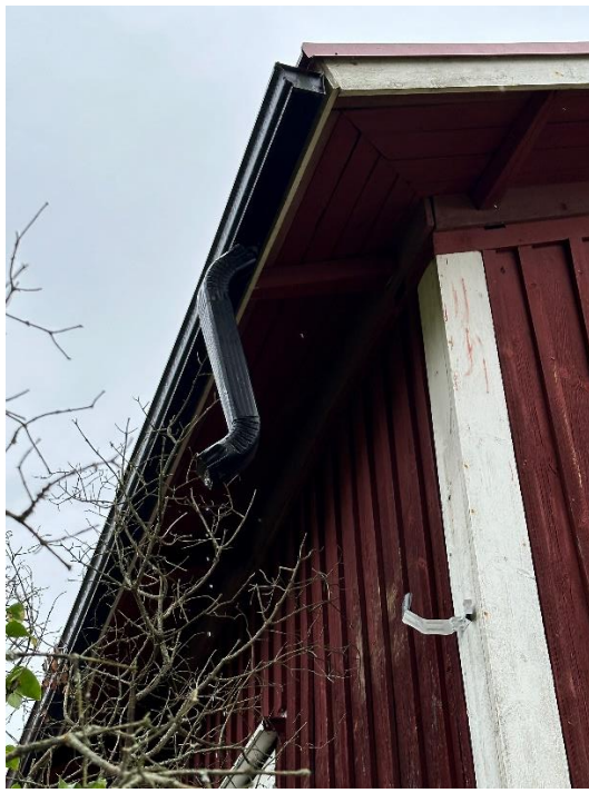
Kuva 16. Syöksytorvi katkaistu
