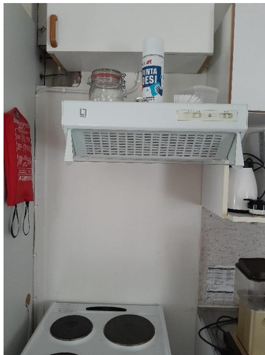
Kuva 40. Liesituuletin aktiivihiihtisuodattimella
