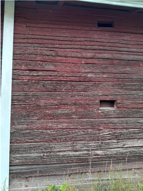
Kuva 24. Aittakahvilan hirsirakenteiset ulkoseinät ovat erittäin huonossa kunnossa
