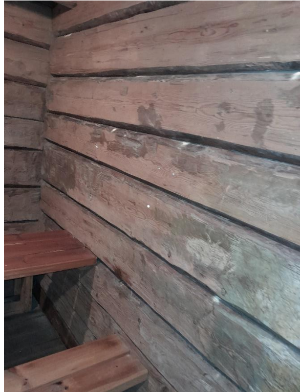
Kuva 26. Hirsirunko sisäpuolelta
